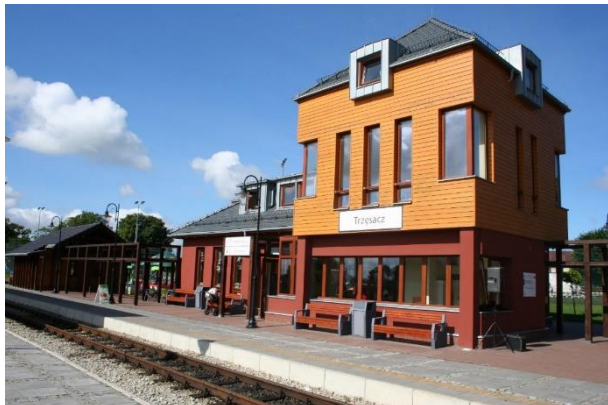
Dworzec w Trzęszczu
