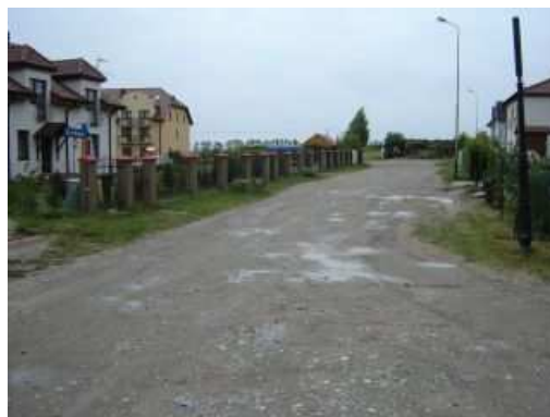
ul. Szczęśliwa – aktualny stan techniczny
