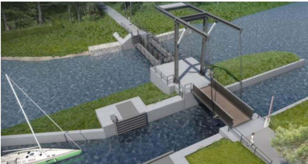
Kładka dla pieszych w obrębie wrót sztormowych
