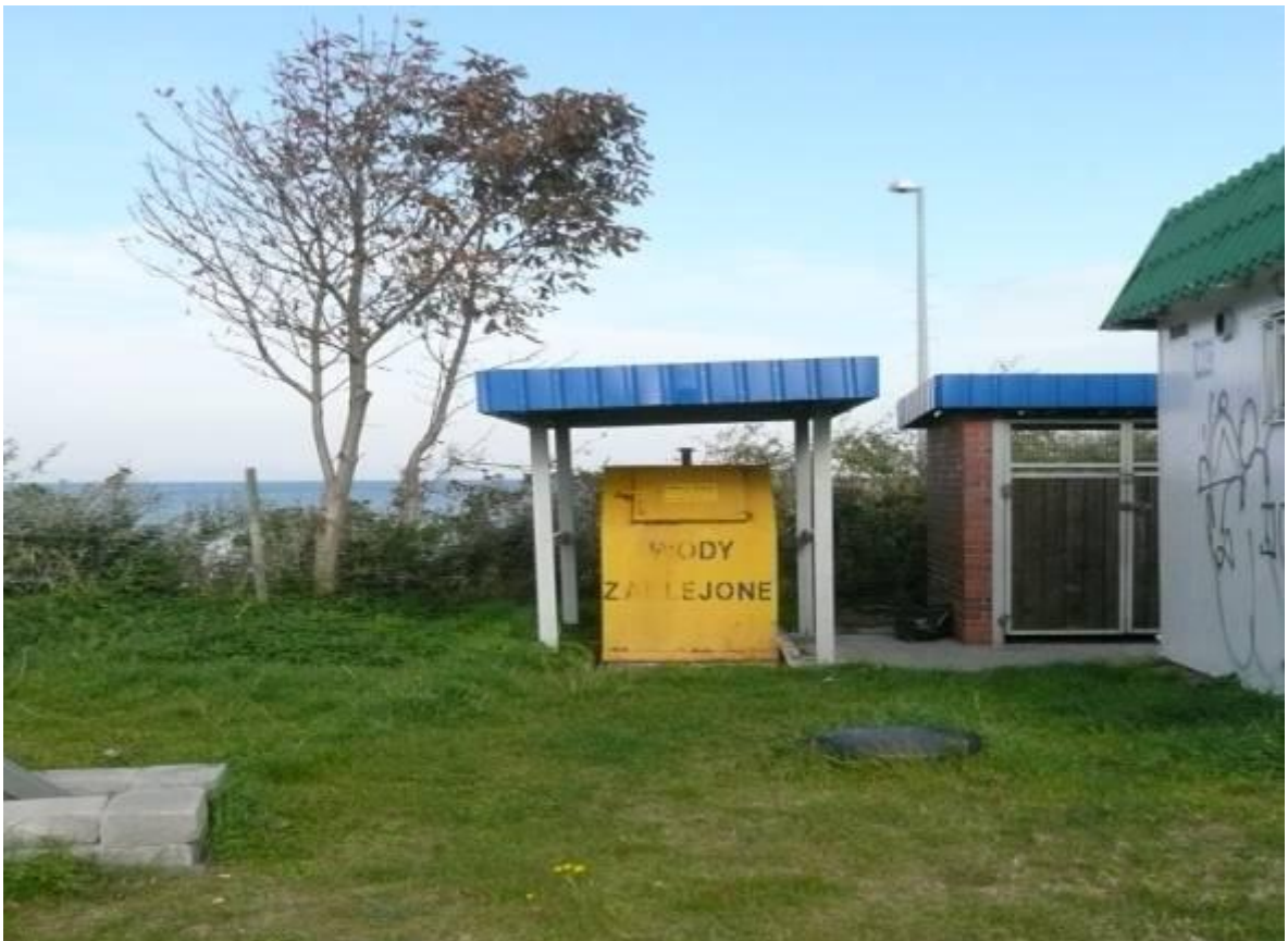
3. zbiornik stalowy na wody zaolejone ( 22.06.1999r.)
